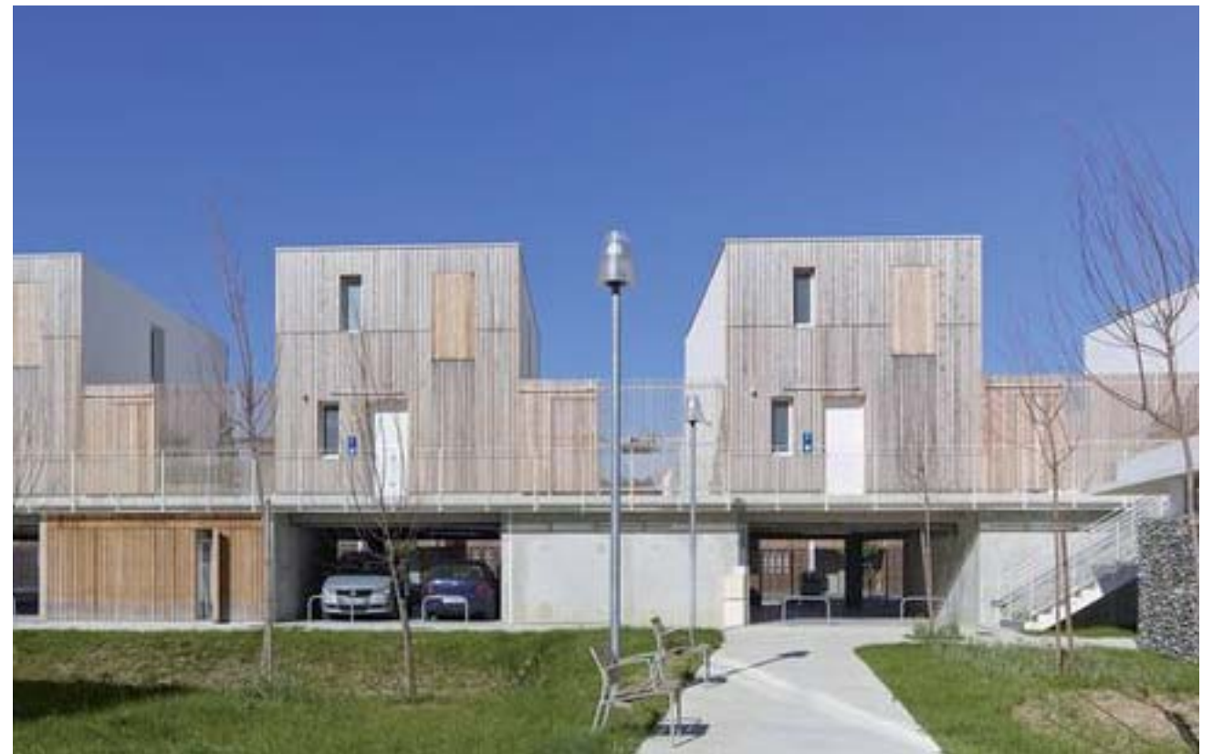
Opération maisons groupées, R+1+A
