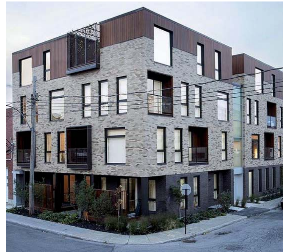
Opération angle de rue
