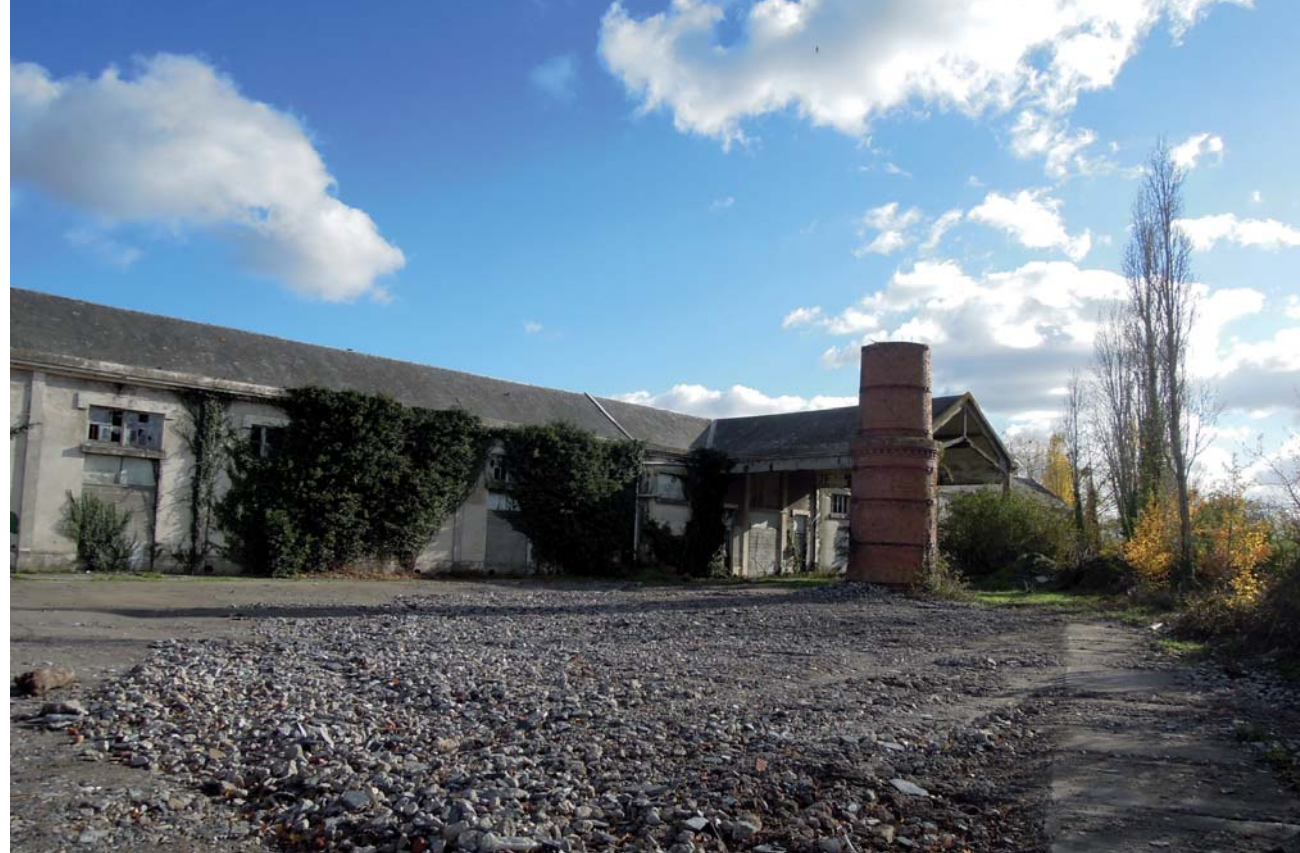
La cheminée - élément patrimonial
