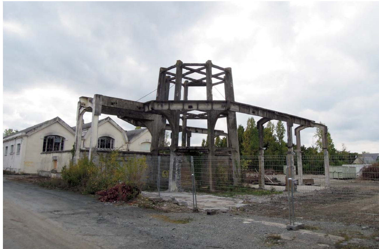
Le château d'eau, en rénovation - élément patrimonial
