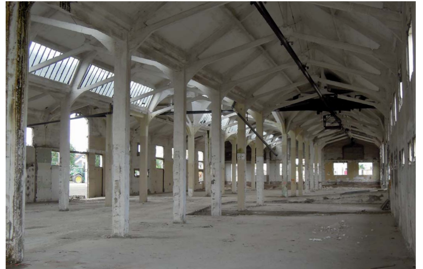
Les halles, avant rénovation - élément patrimonial
