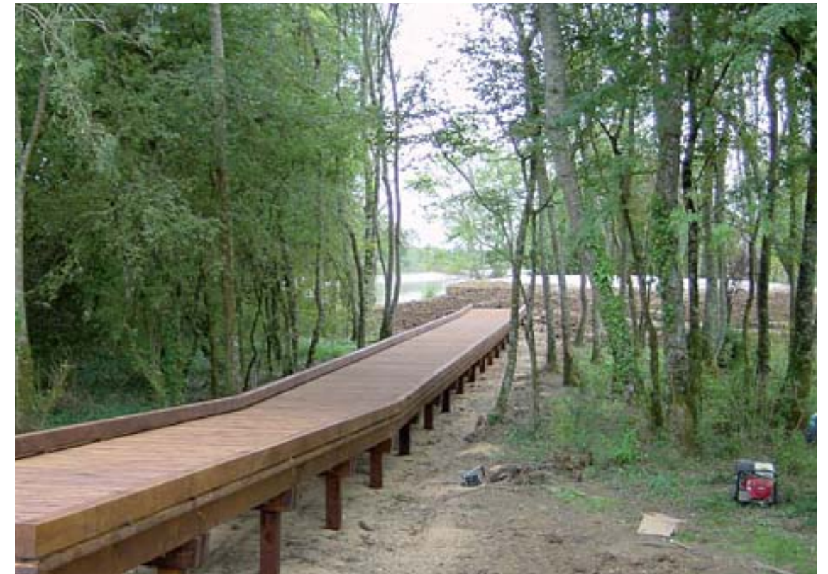
Exemple de réalisation d'une estacade avec chasse roue (sans garde corps)
