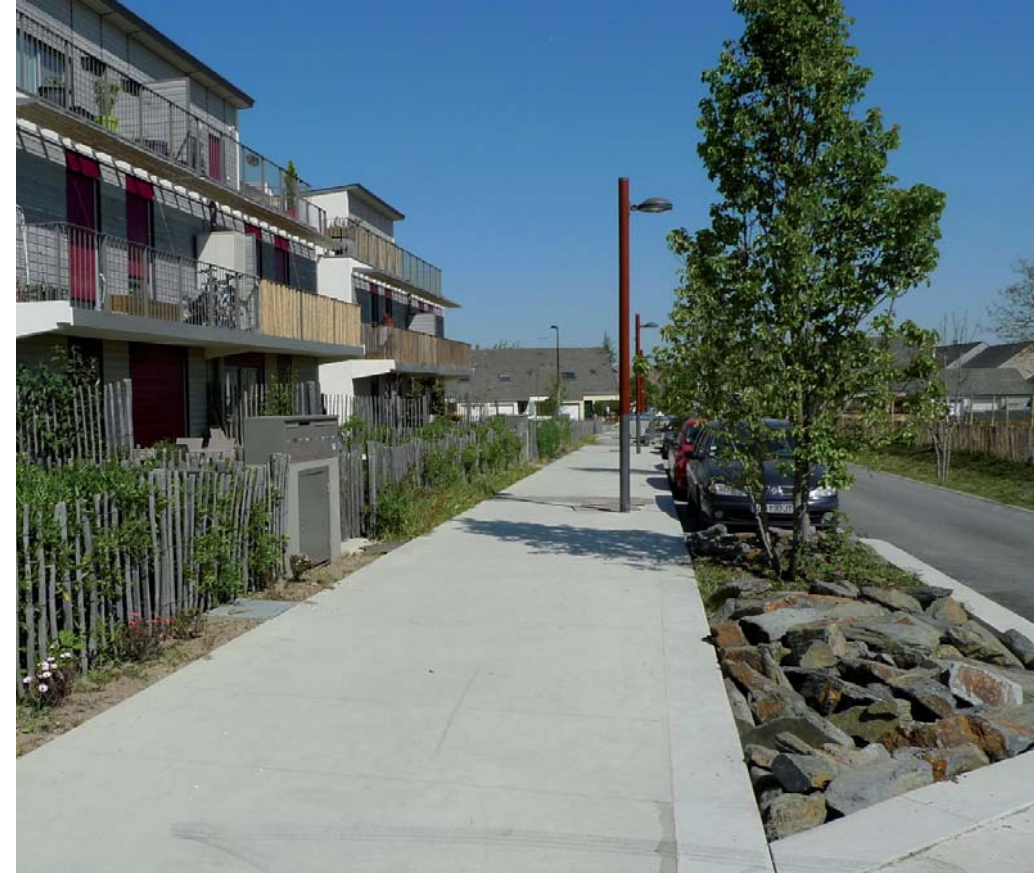
Exemple de béton balayé. Matériaux prévu pour les trottoirs.
