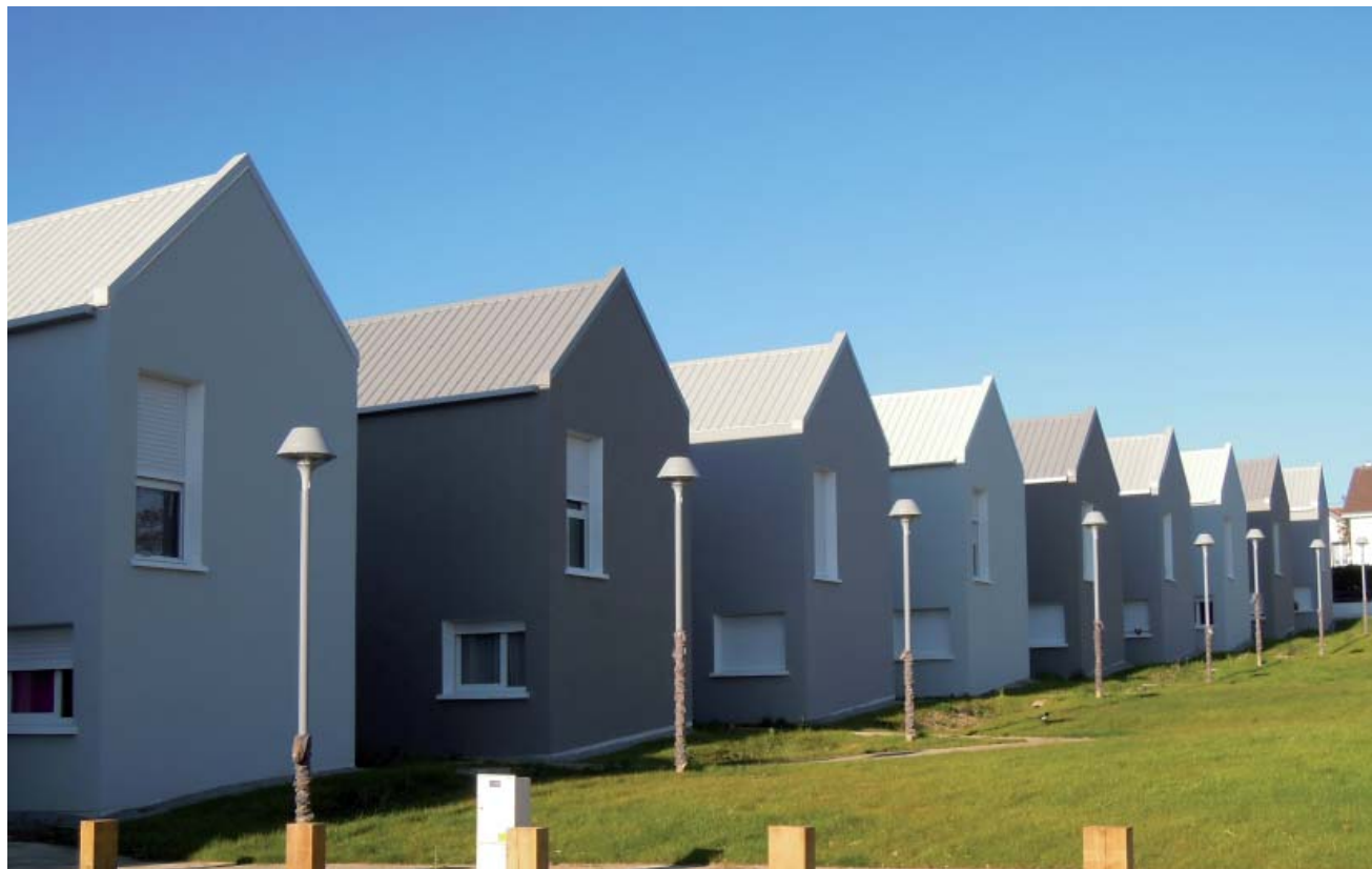
Opération maisons individuelles groupées, St Herblain (44), Magnum Architectes
